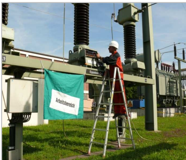
Bild 8: Beispiel zur Kennzeichnung des Arbeitsbereiches mit grüner Flagge.
