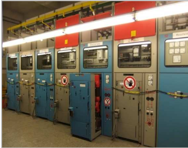
Bild 9: Zeigt eine nach DIN VDE 0101 „Starkstromanlagen mit Nennwechselspannung über 1 kV Teil 1: Allgemeine Bestimmungen“ als luftisolierte konventionelle nicht typ-geprüfte Anlagen. Der Arbeitsbereich ist mittels gelb-schwarzer Ketten und Einsatz von isolierenden Schutzplatten gekennzeichnet.
