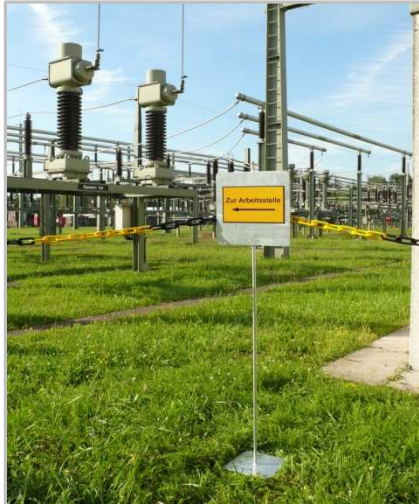
Bild 6: Beispiel zur Einrichtung des Zugangs zum Arbeitsbereich durch Verwendung von gelb-schwarzen Ketten und Zusatzzeichen.
