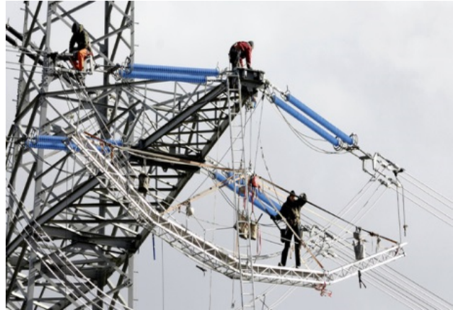
Abbildung 4: Erdung beim Arbeiten auf Freileitungsmasten (Quelle: Amprion)
