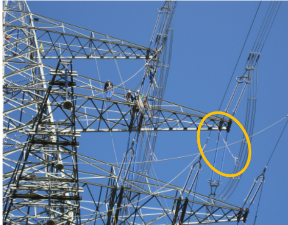
Abbildung 4: Erdung beim Arbeiten auf Freileitungsmasten (Quelle: Amprion)
