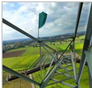
Bild 14 und 15: Zeigt einen Hochspannungsmast mit in Betrieb befindlichen und gleichzeitig freigeschalteten Systemen. Die Kennzeichnung der spannungsfreien Systeme mittels grüner Flaggen erfolgt am Zugang in den Traversenbereich.
