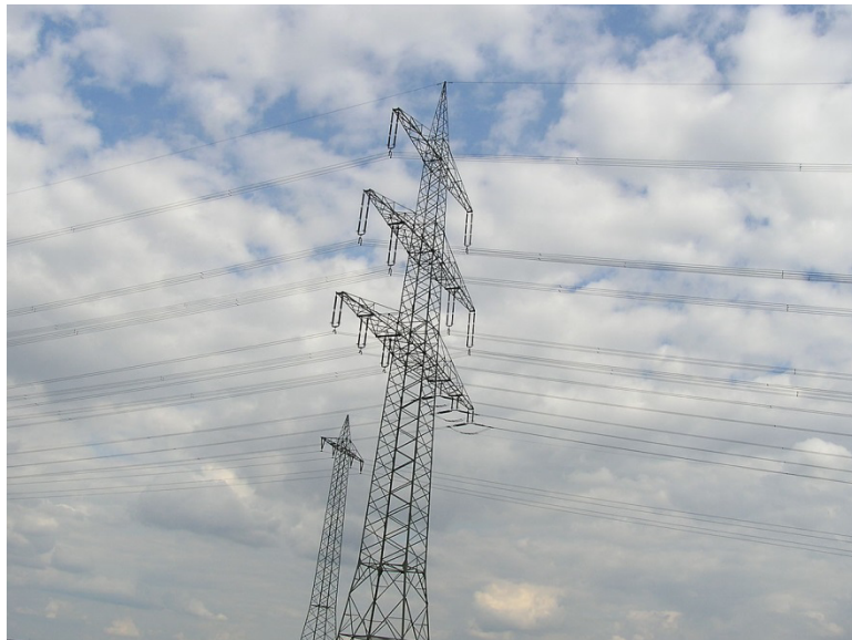
Abbildung 2: Mast (vorne) mit vier Stromkreisen
