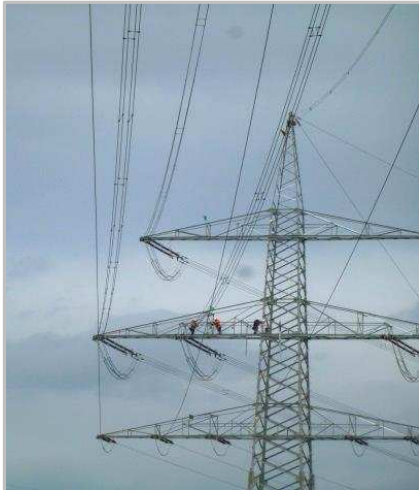
Bild 14 und 15: Zeigt einen Hochspannungsmast mit in Betrieb befindlichen und gleichzeitig freigeschalteten Systemen. Die Kennzeichnung der spannungsfreien Systeme mittels grüner Flaggen erfolgt am Zugang in den Traversenbereich.
