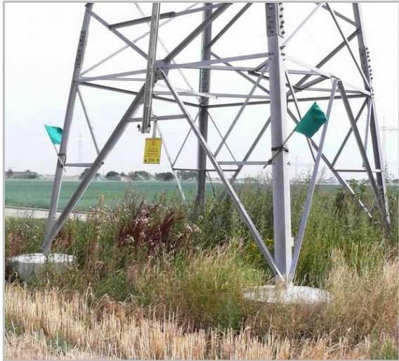
Bild 12 und 13: Zeigen einen zum Arbeiten freigegebenen 110 kV-Hochspannungsmast bei dem beide Stromkreise freigeschaltet sind (Einebene-Traverse). Die Kennzeichnung mittels grüner Flaggen erfolgt im Bereich des Masteinstiegs an den Steiggängen.
