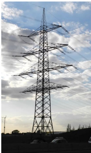
Abbildung 5: Typischer Mast mit 3 Spannungsebenen
