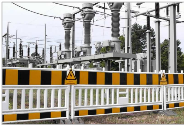
Bild 7: Verwendung von gelb-schwarz markierten Kunststoffzäunen zur Abgrenzung und Kennzeichnung des Arbeitsbereiches.
