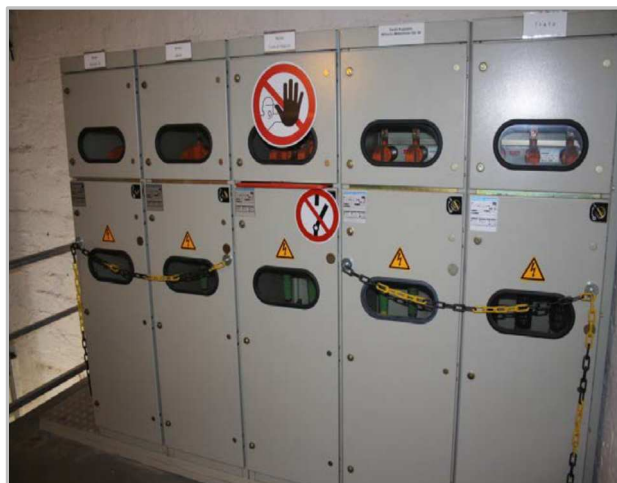
Bild 11: Kennzeichnung des Arbeitsbereiches einer typgeprüften Mittelspannungsnetzstation. Die Kombination aus der Verwendung der gelb-schwarzen Kette sowie des Verbotsschildes D-P006 erhöht hier die Eindeutigkeit.
