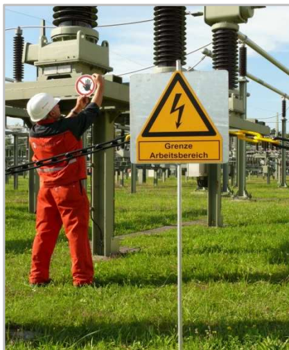
Bild 5: Beispiel zur Abgrenzung und Kennzeichnung des Arbeitsbereiches durch Verwendung von gelb-schwarzen Ketten mit dem Warnschild. Der Gefahrenbereich wird hier zusätzlich mit Hilfe eines Verbotsschildes durch den Anlagenverantwortlichen gekennzeichnet.
