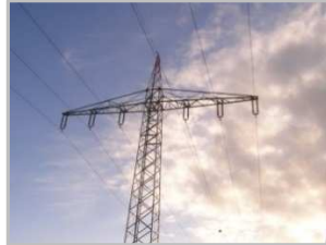
Bild 12 und 13: Zeigen einen zum Arbeiten freigegebenen 110 kV-Hochspannungsmast bei dem beide Stromkreise freigeschaltet sind (Einebene-Traverse). Die Kennzeichnung mittels grüner Flaggen erfolgt im Bereich des Masteinstiegs an den Steiggängen.
