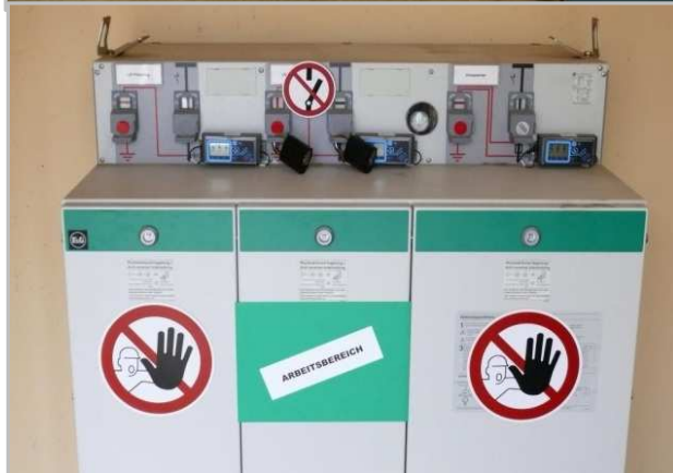
Bild 10: Kennzeichnung bei typgeprüften kompakten Schaltanlagen unter Verwendung einer grünen Farbkennzeichnung für den zum Arbeiten freigegebenen Bereich.
